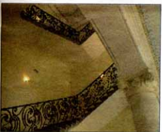
La rampe d'escalier en fer forgé est l'œuvre du ferronnier français Guy Georget.
